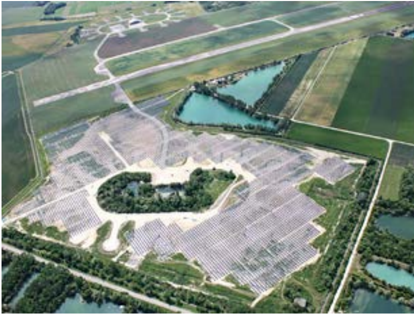
Lassicourt Solar Power Plant (Aube)
