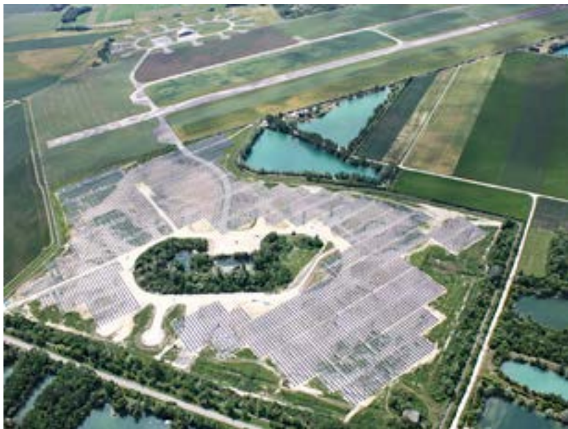
Lassicourt Solar Power Plant (Aube)
