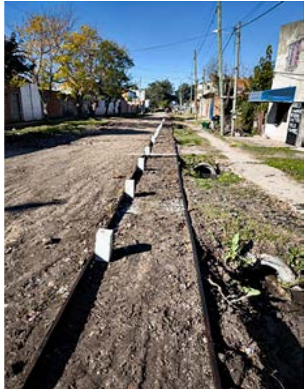
Construction du trottoir. Photo Horacio Bozzano
