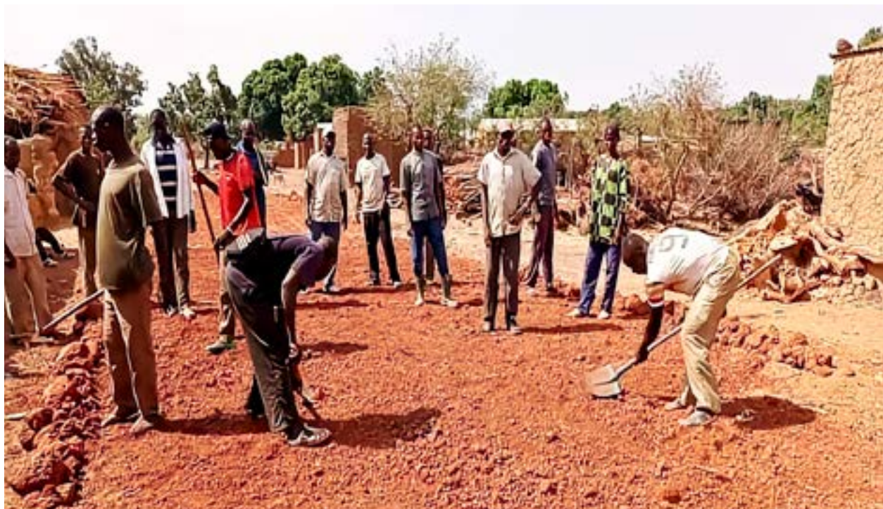
Chantier communautaire des jeunes
