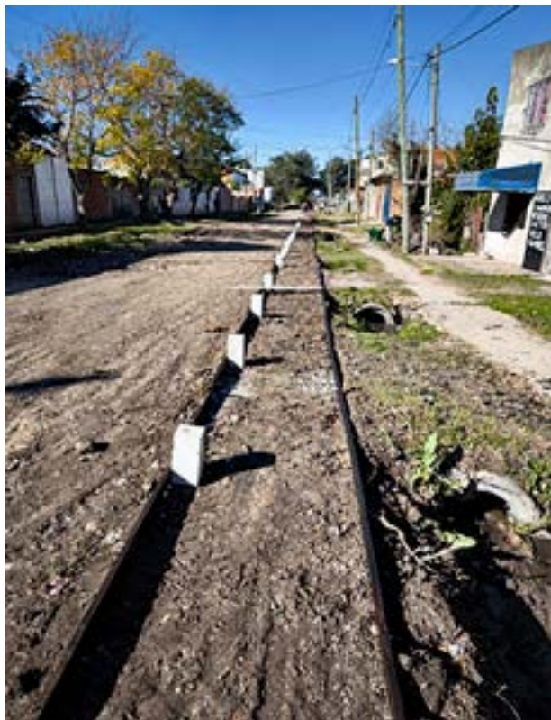
Construction du trottoir. Photo Horacio Bozzano
