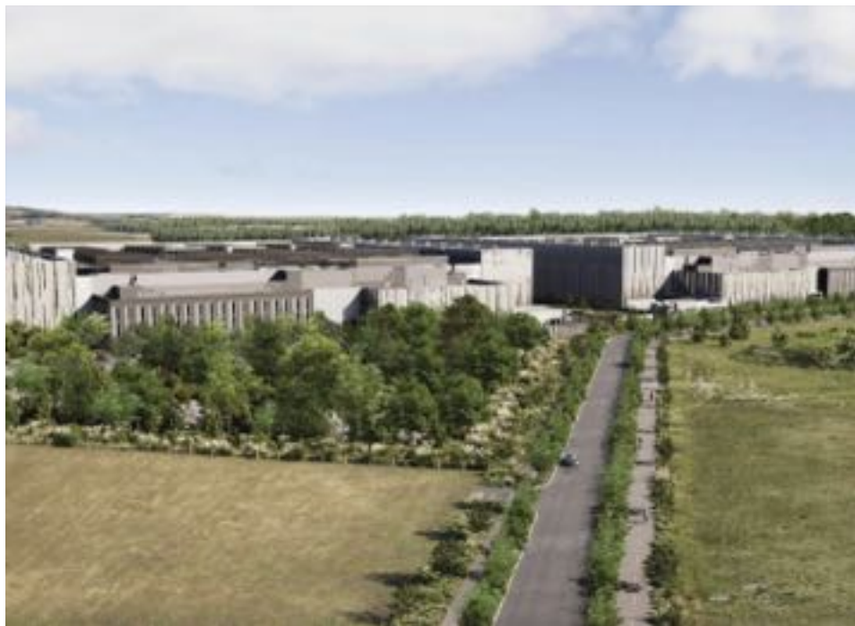
Projet de data center CloudHQ à Lisses (Ile de France)
